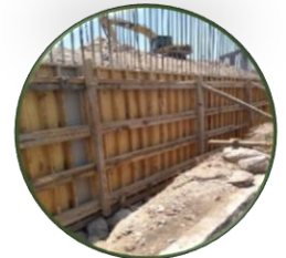
Para la construcción
