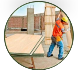
Para la construcción
